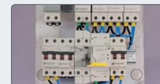
Connecter l'IGA. Vérifier le fonctionnement correct du REC3C, en appuyant sur la touche TEST.
