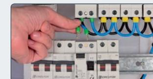
Retirer des bornes l'interrupteur différentiel à remplacer.
